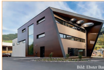
Bild: Ebster Bau
